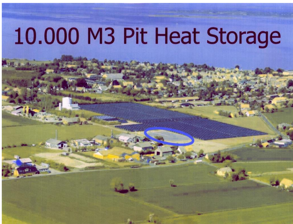
Abb.43: Große Solarwärme-Anlage in Marstal / Dänemark. Der blau-oval markierte Bereich ist der Gruben-Wasserspeicher mit schwimmendem Isolierdeckel. Quelle: Leo Holm (62)
