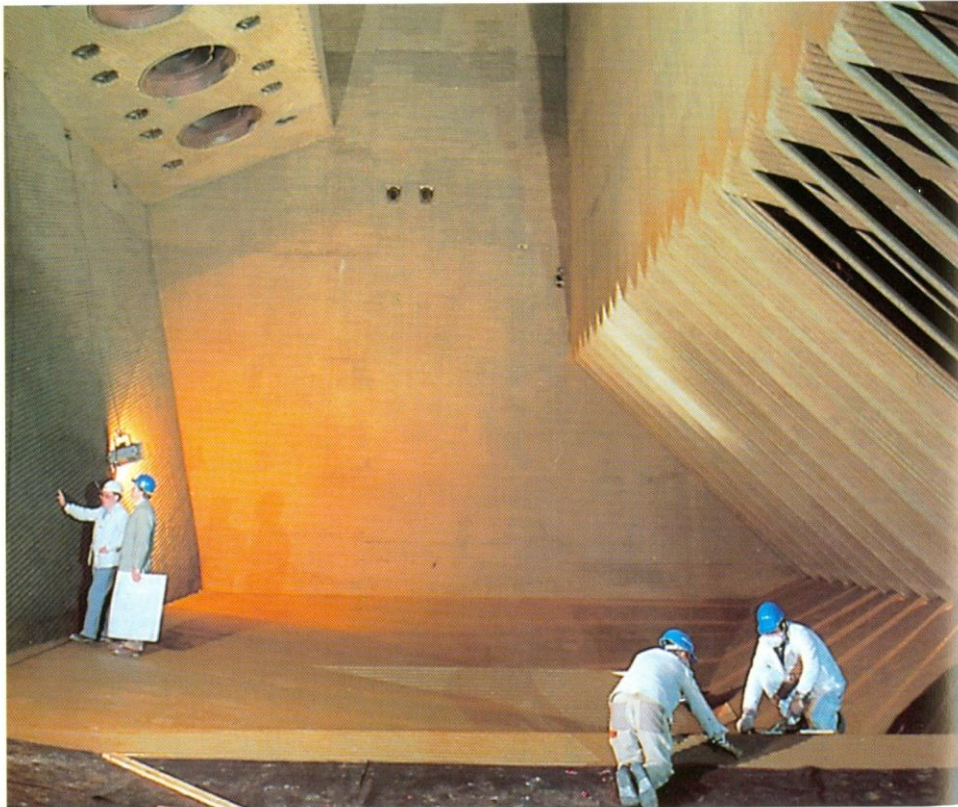
Stufenschmelzkammer eines 770 MW Dampferzeugers (um 1990).
